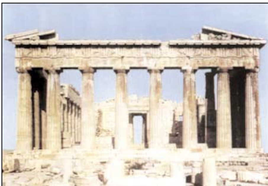
FIGURA 91. El Partenón (fachada oriental), de planta rectangular y proporciones alargadas, la inclinación del eje de las columnas y las cubiertas de las líneas horizontales cooperan en la armonía del templo. (Grecia).
